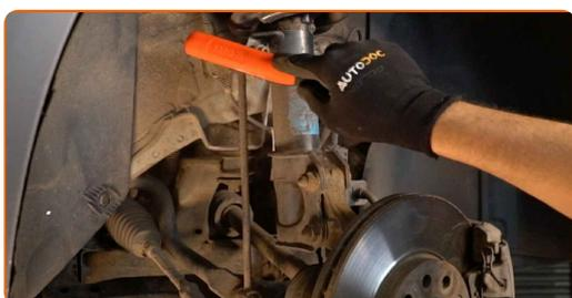
**14** Svitare il dado e rimuovere la barra stabilizzatrice dal supporto di ammortizzazione. Utilizza una chiave combinata N°19. Utilizza una chiave a bussola N°19. Usa una chiave a cricchetto.
