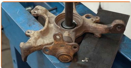
**31** Rimuovere la gabbia interna del cuscinetto dal mozzo della ruota. Usare un set di montaggio/smontaggio cuscinetti e boccole. Usare un separatore cuscinetti.
