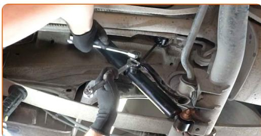
**15** Sostieni la traversa posteriore della sospensione. Usa un cric idraulico per trasmissione.
