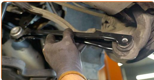
Sostituzione: braccio inferiore posteriore - MERCEDES-BENZ Classe E Cabriolet (A238). I professionisti raccomandano:
