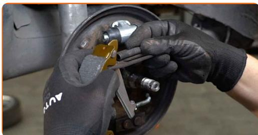
**22** Installare le ganasce del freno sul cilindretto apriaceppi e sulla staffa del supporto.
