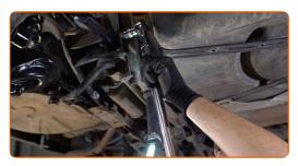
Serra gli elementi di fissaggio che collegano il braccio di sospensione allo snodo posteriore. Utilizza una chiave a bussola N°15. Usa una chiave dinamometrica. Serralo fino allo coppia di torsione di 115 Nm.
